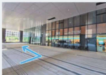
⑤突き当たり「ファミリーマート」のとなり、カワサキデルタビル入口より
